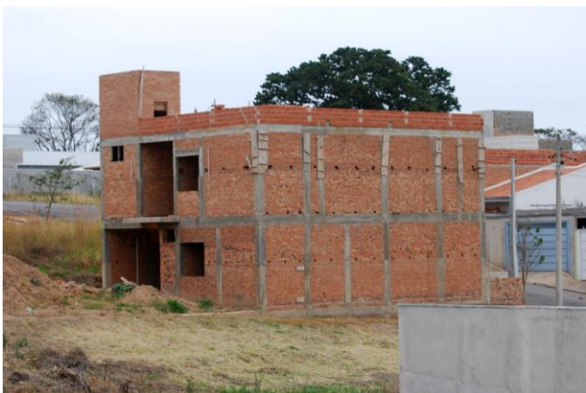
Foto 19 – Área de Vizinhança Imediata – AVI – Residência em construção no loteamento Recanto da Serra I. Verifica-se um grande dinamismo de ocupação do loteamento.
